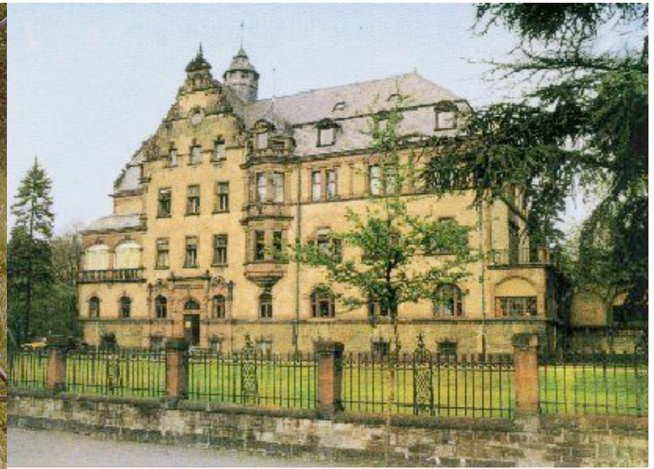
Physikzentrum at Bad Honnef
